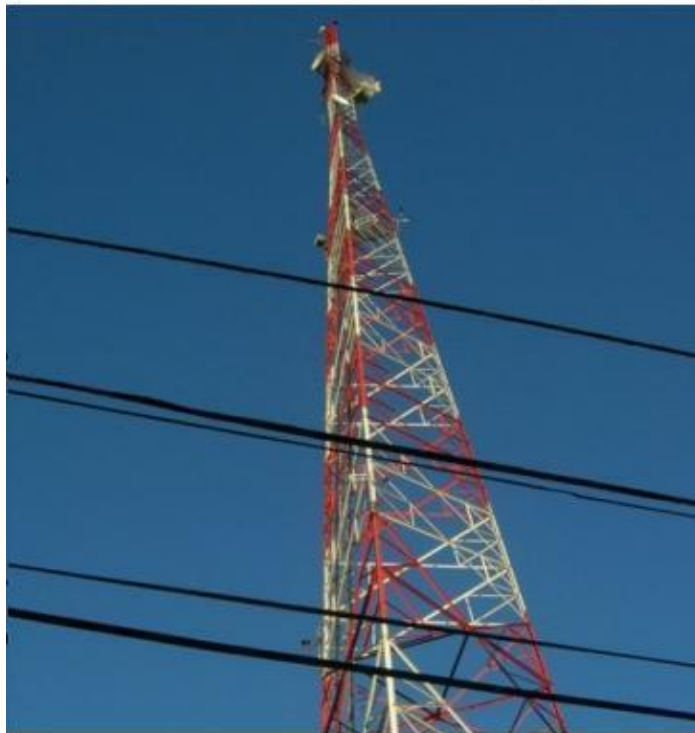
Antenas de telefonía celular instaladas en el Área Metropolitana
